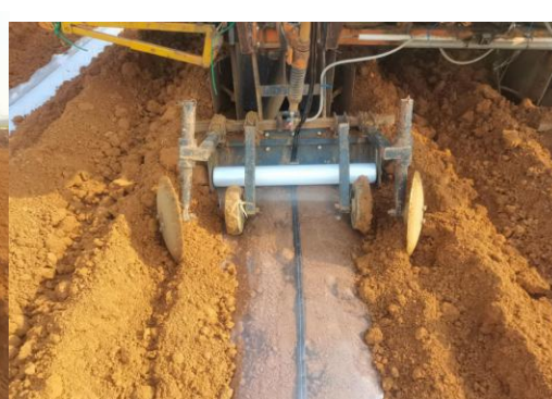
图 9 机械盖膜铺管
